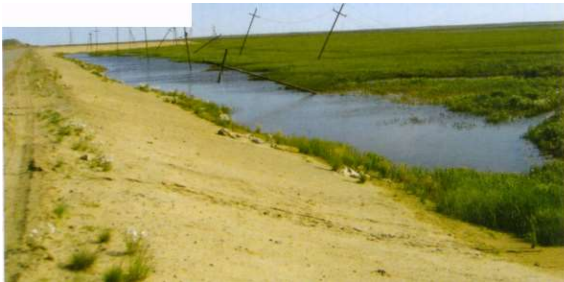
Рис. 4.34. Состояние объекта инфраструктуры (ЛЭП), находящегося в зоне развития геокриологического процесса: на снимке (вверху, красные линии) и на местности (внизу)
