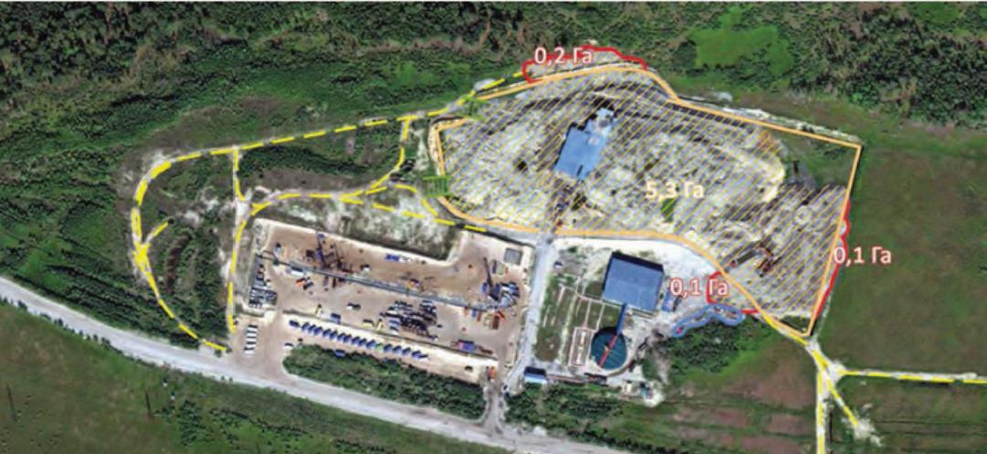
Нарушение обваловки территории завода по переработке шлама
